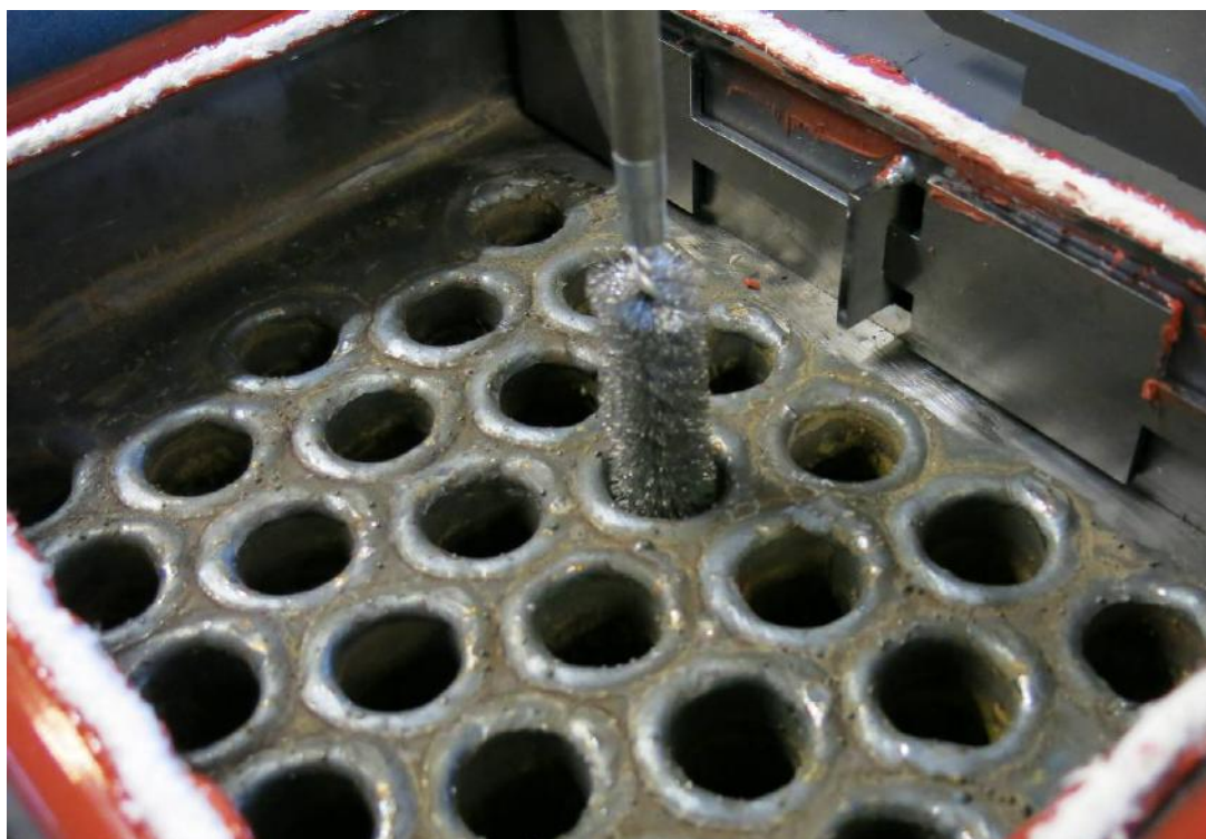
Рис. 37 - Чистка трубчатого теплообменника
