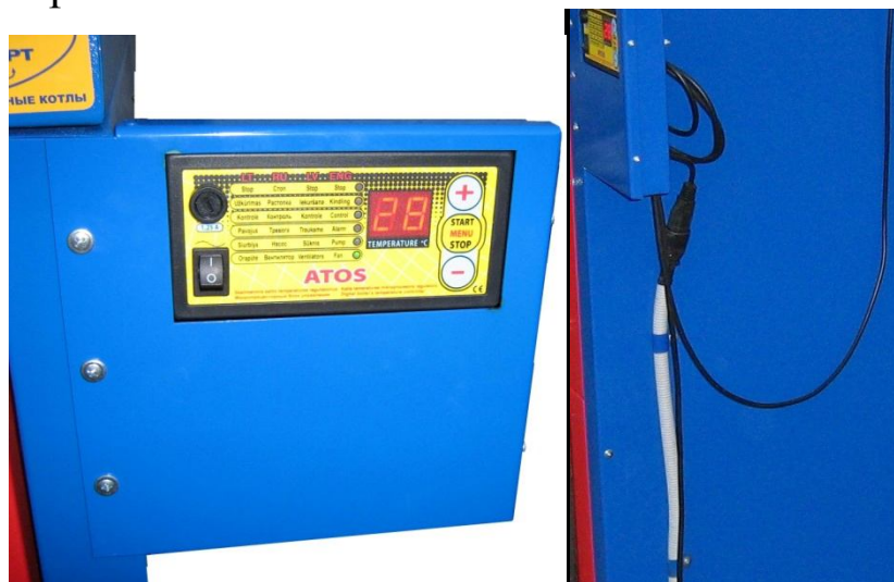
Рисунок 5 – Установка блока управления
