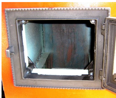
Рисунок 5 – Топочная дверка котла
